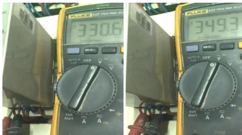
Gambar 6. Pengukuran Tegangan Phase Failure Rele saat Kehilangan Tegangan Satu Fasa
